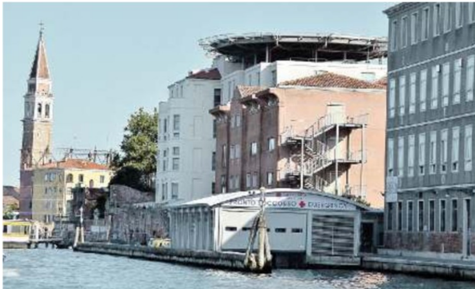
L'AMMODERNAMENTO La nuova darsena del Civile con l'elisoccorso, due degli interventi degli ultimi anni
